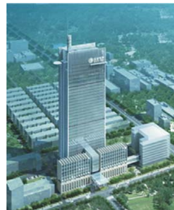
河南电力综合调度楼
